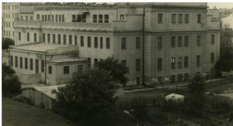
Fotografia 3. Gmach Domu Żołnierza w Lublinie w którym w 1944 roku otwarto Centralny Dom Żołnierza.
